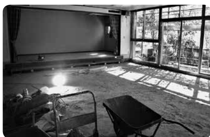
▲ 改修中の大広間
