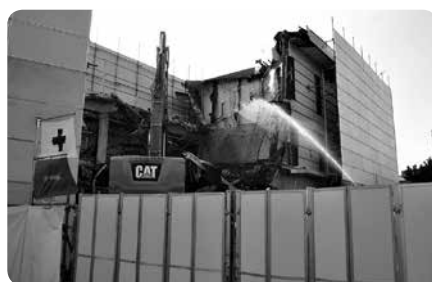
▲ 解体中の3階建て部分
